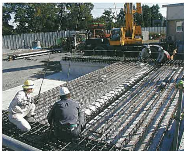
8.0m支間スラブの施工実験
